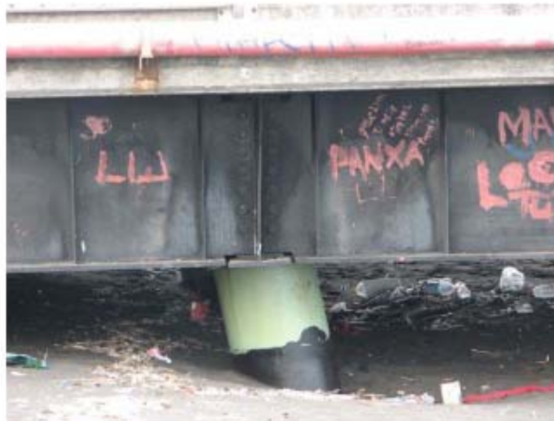
FIG.1 PILOTE INCLINADO POR DESPLAZAMIENTO SISMICO DEL SUELO
