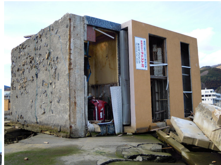
Edificio de 3 pisos con losa de fundación en Onagawa
